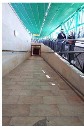
Rampe per accedere al piano -1 della Stazione
