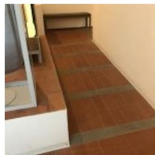
La Sala 27 ha una strana conformazione, dovuta ad un dislivello nel piano stesso dell'edificio. Presenta difatti un pavimento in pendenza all'11% su quasi 7 metri di lunghezza. Al centro della stanza è inoltre presente una base in cemento che limita ad una larghezza di 140 cm lo spazio utile più stretto per attraversare il locale. Essendo l'ultima stanza del percorso prima di tornare all'ascensore, può essere attraversata scendendo.
