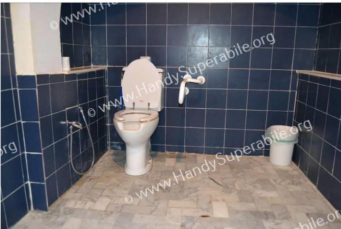
Nei pressi del ristorante principale, al piano -1, a lato dell'ascensore, troviamo servizi igienici attrezzati, raggiungibili tramite 2 scalini di 16 cm, superabili tramite una rampa lunga 320 cm, larga 93 cm e con pendenza c.a. 10%. Luce netta porta d'ingresso di 90 cm. e maniglia a leva. Il wc è dotato di maniglione di sostegno sul lato sinistro con spazio libero a dx di 35 cm e superiore a 90 cm sul lato sx e frontale. Il lavabo ha uno spazio sottostante di 70 cm ed è regolabile.
