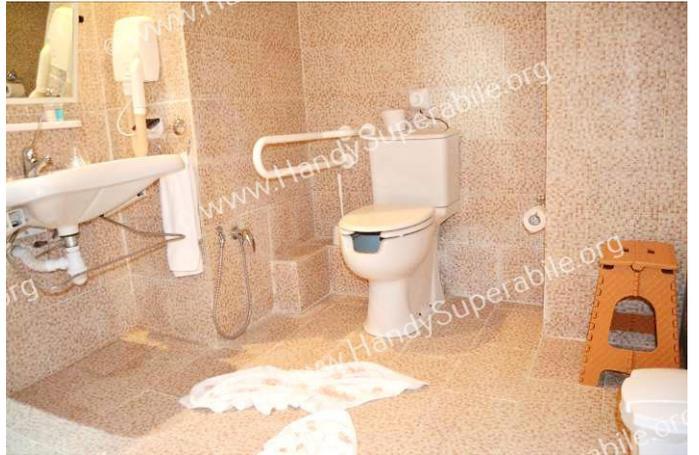
La porta d'ingresso è larga 90 cm con maniglia a pomello e apribile verso l'interno. Il wc, di tipo discontinuo (dente frontale aperto), è alto 50 cm, dotato di maniglione di sostegno sul lato destro, alto 87 cm, di doccetta flessibile, priva di termostato e di campanello d'allarme a corda.
