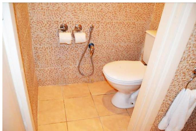
Porta con luce netta 66 cm; Il wc alto 40 cm, di tipo continuo, con spazio a sx e a dx 20 cm e spazio frontale di 58 cm; la camera è dotata di box doccia (173 X 90 cm) accessibile tramite varco largh. 85 cm con uno scalino di 11 cm. La doccia dispone di rubinetteria a leva ed è privo di maniglione di sostegno. Il lavabo è incassato in un mobile in muratura ed è privo di spazio sottostante per accostamento.
