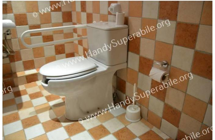
Nella hall sono presenti servizi igienici attrezzati con luce netta porta d'ingresso di 90 cm. e maniglia a leva. Il wc è dotato di maniglione di sostegno sul lato destro con spazio libero su entrambi i lati e frontale superiore a 100 cm. Il lavabo ha uno spazio sottostante di 70 cm ed è regolabile.
