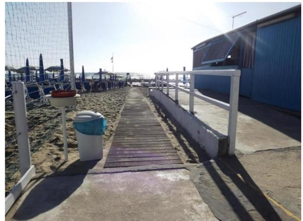
La spiaggia è in concessione, raggiungibile tramite rampa: lung. 116 cm, largh. >90 cm, pendenza 9 %.
