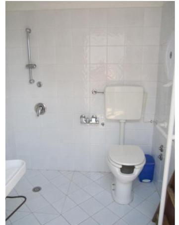
I servizi igienici accessibili sono raggiungibili tramite uno scalino alto c.a. 10 cm superabile con rampetta amovibile. La larghezza della porta è 85 cm, il sedile wc ha il dente frontale aperto con altezza da terra cm 50; spazio di manovra a sx del wc 21 cm, a dx e frontale superiore a 100 cm; è presente un maniglione di sostegno a sinistra del wc fisso a parete ed una doccetta flessibile; la profondità sottostante il lavabo è 68 cm con specchio non fruibile da un ospite in carrozzina.
