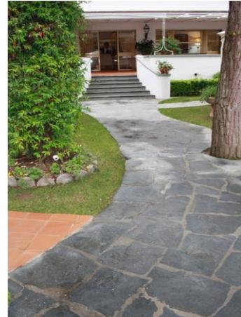
L'ingresso principale è raggiungibile tramite una rampa lunga cm.1.150 larga cm.124 con pendenza del 6% c.a. e la porta principale a doppia anta con larghezza superiore a cm.100.
