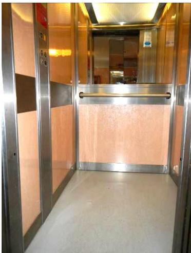
L'ascensore dell'albergo è moderno e spazioso. Le dimensioni interne sono di 140 x 108 cm mentre la porta di ingresso è larga 78 cm. La pulsantiera interna e il pulsante di chiamata hanno i numeri in rilievo e scritti in braille e all'interno è presente un segnale sia luminoso che sonoro per il raggiungimento del piano. Sul fondo è presente un maniglione.
