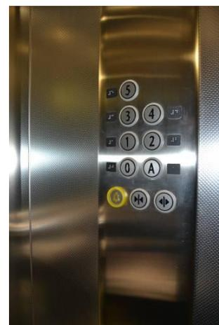
Nelle foto l'ascensore che serve il piano ammezzato dove si trovano bar, ristorante e sale meeting: luce netta porta scorrevole cabina di 80 cm, interno cabina con largh. 99 cm e prof. 130 cm, dotato di maniglia di sostegno. Pulsante di chiamata, in braille e rilievo, posto a 110 cm di altezza da terra e tastiera con comandi in rilievo/braille con il tasto più alto posto a 122 cm da terra.
