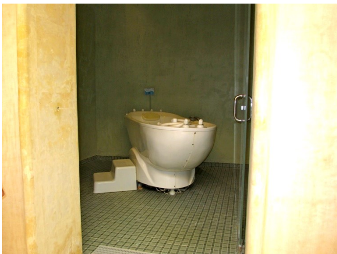
Porta d'ingresso sala con vasca idromassaggio larga 105 cm e altezza della vasca 86 cm
