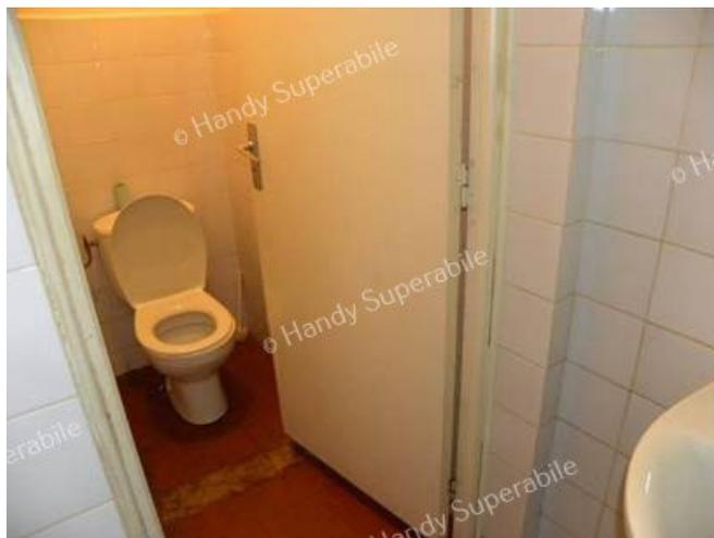
Nell'aerostazione sono presenti servizi igienici accessibili separati per maschi e femmine ma con il locale wc che risulta inaccessibile alle persone in sedia a rotelle a causa degli spazi troppo stretti, anche se le porte e l'antibagno permettono il passaggio di una carrozzina manuale
