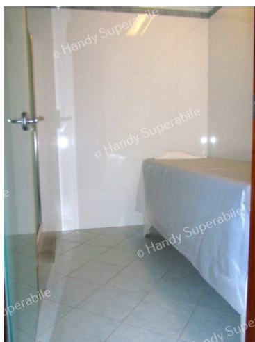
Le cabine idrogetto/impacco : luce netta porta 77 cm, lettino regolabile in altezza tramite comando elettrico. La doccia interna ha luce netta 71 cm e un gradino di 12 cm
