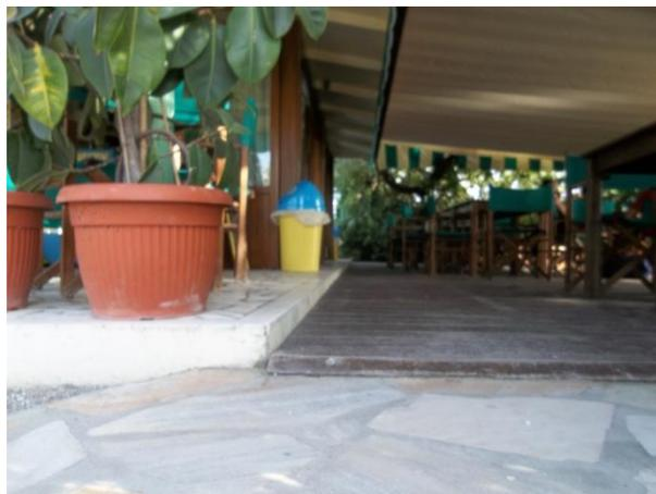
Il **bar/ristorante** è accessibile con gradino di cm.6 superabile con rampa lunghi 50 cm largh. 100 e pend 12%
