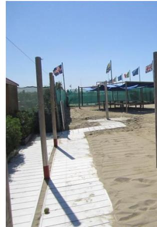
I servizi igienici accessibili sono raggiungibili tramite una rampa con dislivello di 53 cm, lunga 600 cm, larga > 90 cm, con pendenza 7,5% .
