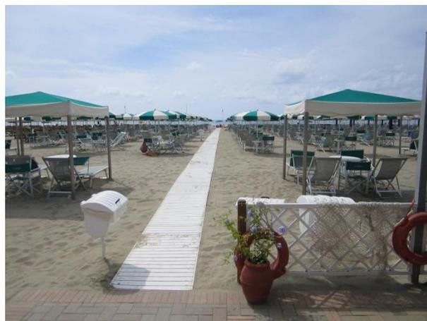
Si accede alla passerella centrale tramite una rampa lunga 130 cm, larga >100 cm, con pendenza 20%. La passerella in pvc è larga 90 cm e conduce alla prima fila di ombrelloni.
