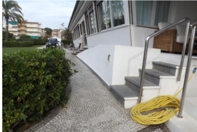
Il bar è raggiungibile tramite rampa: lungh. 640 cm, largh. 97 cm, pendenza 12%., cordolo ad entrambi i lati.
