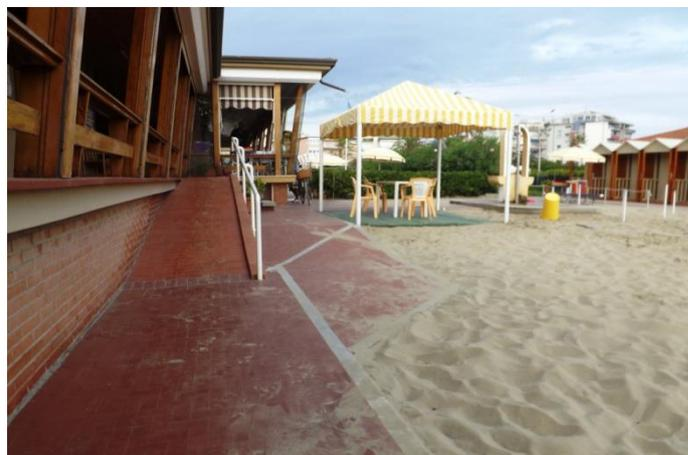
Lo snack bar/self service è raggiungibile tramite una prima rampa in discesa: lungh. 185, largh. >100 cm e pendenza % e successiva rampa in salita: lungh. 600 cm, largh. >100 cm, pendenza 14-16 %.
