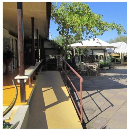
Lo stabilimento balneare dispone di un **bar/ristorante** e di una veranda all'aperto con i tavoli, il ristorante è raggiungibile tramite 3 rampe con largh. >100 cm: la 1° rampa lunga 130 cm, con pendenza 10%; la 2° rampa lunga 120 cm, con pendenza 20% ; la 3° rampa lunga 7 m, con pendenza 6% e corrimano a dx e cordolo a sx; La veranda è raggiungibile invece tramite una rampa lunga 140 cm, larga >100, con pendenza 13%.
