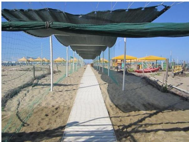
Si accede alla passerella centrale tramite una 1° rampa: lungh. 120 cm, largh >100 cm, con pendenza 13% ed una rampetta di 40 cm, larga >100 cm, con pendenza 11% .
