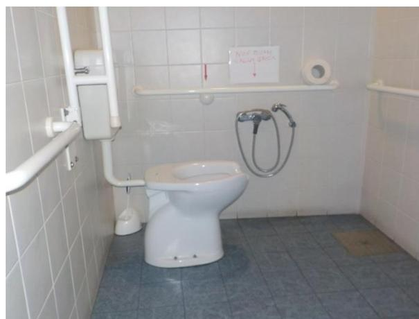
**Accessibilità: porta d'ingresso a vetri con maniglia a leva, largh. > 80 cm, e rampetta di raccordo liscia. La porta d'ingresso ai servizi igienici attrezzati ha una luce netta > 90 cm con wc a dente frontale aperto, dotato di maniglia di sostegno ad entrambi i lati e frontale e doccetta flessibile. Spazio laterale destro e frontale superiore a 100 cm. Lavabo con spazio sottostante superiore a 70 cm e specchio fruibile da una persona in carrozzina.**
