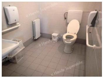
Nei pressi del Ristorante, troviamo i **servizi igienici** comuni, accessibili in piano, con luce netta porta d'ingresso cm 98 e maniglia a leva; il wc, con dente frontale aperto, è dotato di maniglione di sostegno, fisso a parete, sul lato sinistro, con spazio libero a sinistro di 30 cm, destro e frontale >100 cm.
