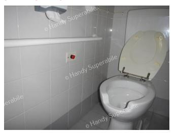
Altri servizi igienici comuni si trovano nei pressi della sala colazione, accessibili in piano, con luce netta porta d'ingresso cm 98 e maniglia a leva; il wc, con dente frontale aperto, è dotato di maniglione di sostegno, fisso a parete, a destro, e spazio libero a sinistro di 110 cm, destro spazio libero di 30 cm e frontale >100 cm.
