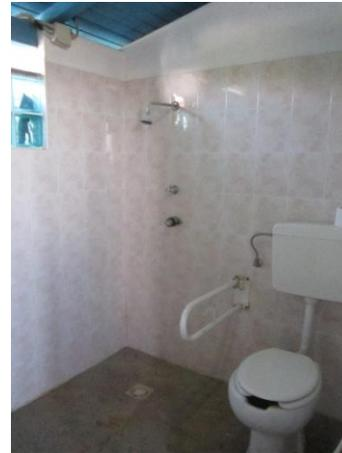
I servizi igienici accessibili sono raggiungibili tramite 1 piccolo scalino di 3 cm. La larghezza utile della porta è 87 cm. Il sedile wc ha il dente frontale aperto con altezza da terra cm 50; spazio di manovra a sx del wc 24 cm, a dx e frontale al wc superiore a 100 cm; è presente un maniglione di sostegno a destra del wc reclinabile; è presente un campanello elettrico a corda; la profondità sottostante il lavabo è 67 cm. Specchio non fruibile da un ospite in carrozzina.
