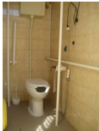
I servizi igienici accessibili sono raggiungibili in piano. La larghezza utile della porta è 83 cm, sedile wc con parte frontale aperta ed altezza da terra cm 50; spazio di manovra alla sx del wc di 23 cm, alla dx 120 cm e frontale 100 cm; il wc è dotato di maniglione di sostegno ad entrambi i lati del wc; è presente un campanello di allarme a corda; la profondità sottostante il lavabo è 74 cm, con rubinetto a leva.
