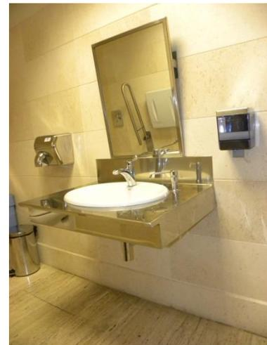
Nell'aerostazione sono presenti diversi servizi igienici – ben segnalati – e attrezzati per portatori di handicap, sia al piano dell'imbarco/sbarco che al piano inferiore del check in, con porta larga 90 cm; il wc ha un sedile privo di dente frontale aperto e di doccetta flessibile ed è dotato di maniglione di sostegno fisso da un lato e reclinabile all'altro lato. Il lavabo ha uno spazio sottostante superiore a 70 cm.
