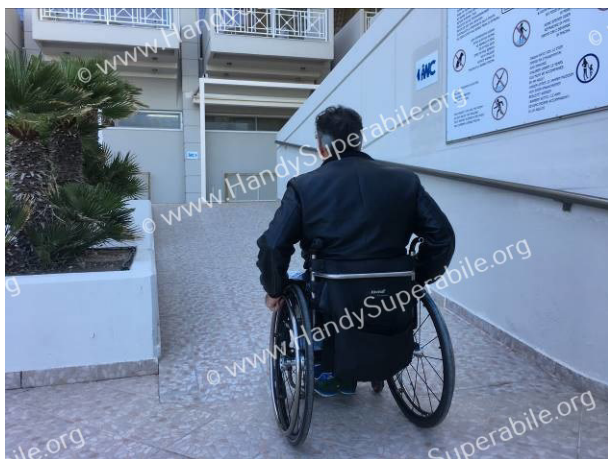
Rampa per raggiungere ping-pong e biliardo
