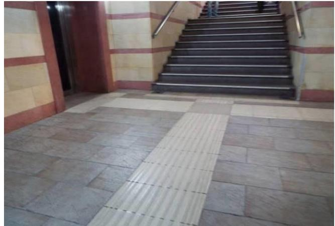
*La porta della cabina dell'ascensore ha una luce netta 89 cm, largh. 138 cm e prof. 150 cm; pulsante esterno di chiamata altezza 120 cm, in braille e rilievo, e tasto più alto della tastiera interna h= 118 cm in rilievo. Il corridoio lungo il quale si trovano gli altri ascensori che conducono ai vari binari dispone di segnali tattili in sistema loges per favorire l'orientamento ai non vedenti.*
