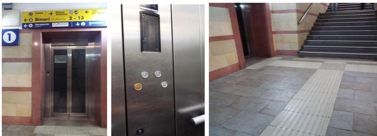
*La porta della cabina dell'ascensore ha una luce netta 89 cm , largh. 138 cm e prof. 150 cm; pulsante esterno di chiamata altezza 120 cm, in braille e rilievo, e tasto più alto della tastiera interna h= 118 cm in rilievo. Il corridoio lungo il quale si trovano gli altri ascensori che conducono ai vari binari dispone di segnali tattili in sistema loges per favorire l'orientamento ai non vedenti.*
