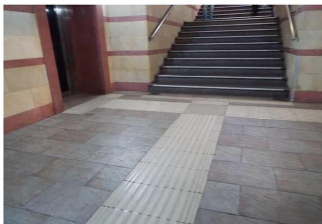
*La porta della cabina dell'ascensore ha una luce netta 89 cm , largh. 138 cm e prof. 150 cm; pulsante esterno di chiamata altezza 120 cm, in braille e rilievo, e tasto più alto della tastiera interna h= 118 cm in rilievo. Il corridoio lungo il quale si trovano gli altri ascensori che conducono ai vari binari dispone di segnali tattili in sistema loges per favorire l'orientamento ai non vedenti.*
