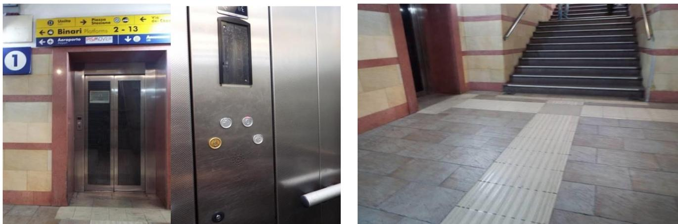
*La porta della cabina dell'ascensore ha una luce netta 89 cm , largh. 138 cm e prof. 150 cm; pulsante esterno di chiamata altezza 120 cm, in braille e rilievo, e tasto più alto della tastiera interna h= 118 cm in rilievo. Il corridoio lungo il quale si trovano gli altri ascensori che conducono ai vari binari dispone di segnali tattili in sistema loges per favorire l'orientamento ai non vedenti.*
