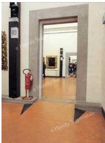
Rampa da sala 75 a 83
