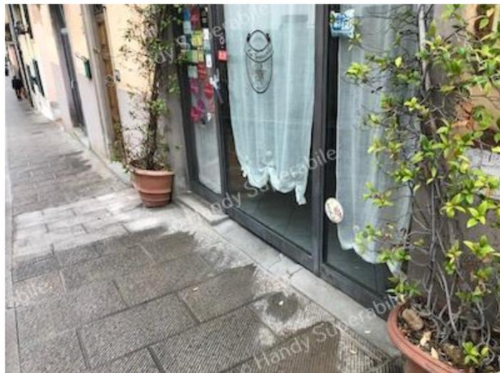
La porta d'ingresso ha una larghezza utile superiore a 100 cm e maniglia a barra. Apre verso l'interno con sforzo moderato. E' presente una piccola rampa di raccordo per colmare il dislivello tra marciapiede e ingresso.
