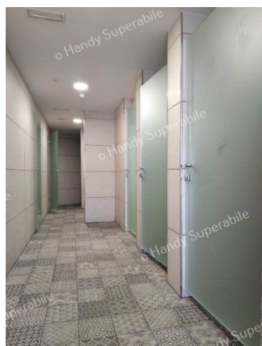
CORRIDOIO CON TRE TOILETTE
