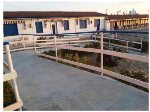
La spiaggia è in concessione, raggiungibile tramite 2 rampe speculari interrotte da 2 ripiani di sosta: lungh. 3m + 3m + 2m, largh. >100cm, pendenza 7%., corrimano ad entrambi i lati.
