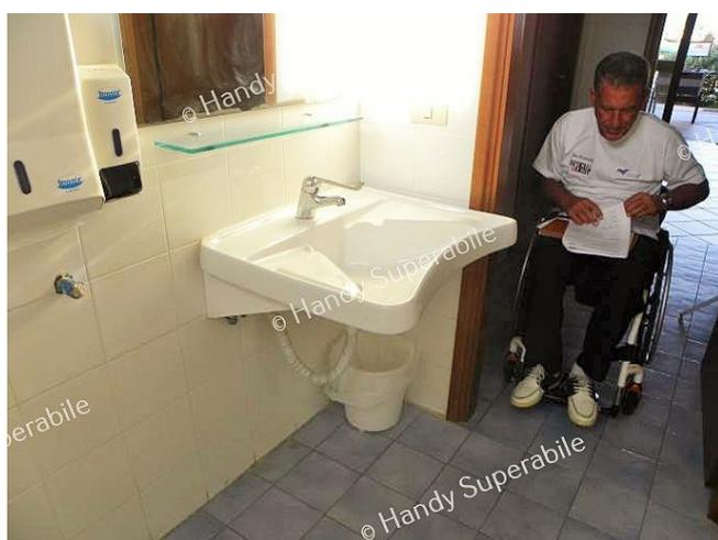
All'interno del bar si trovano servizi igienici attrezzati per portatori di handicap con porte di ingresso di 78/80 cm di luce netta. Il wc è dotato di maniglioni di sostegno reclinabile a sx e fisso a dx., con spazio a sx di 70 cm e a dx di 38 cm. Il lavabo si trova ad un'altezza di 75 cm con spazio sottostante di 81 cm.
