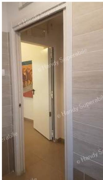
I servizi igienici comuni sono raggiungibili attraverso una porta esterna con maniglia a leva e apertura verso esterna. Successivamente varcata la porta esterna, sul lato destro è collocata una ulteriore porta interna di tipo scorrevole con larghezza utile di 85 cm.
